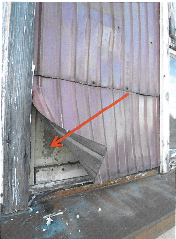
Foto č. 5 – Lokalizace místa odběru vzorku č. 3. dvoupodlažní část VB, 2.NP, vně m.č. 201. Azbestová deska v konstrukci meziokenní vložky pod vnějším plechovým obkladem.
