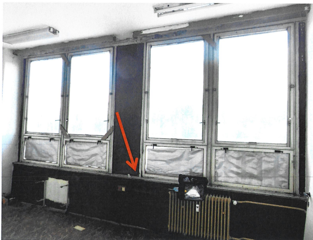
Foto č. 4 – Lokalizace místa odběru vzorku č. 2. Dvoupodlažní část VB, 2.NP, m.č. 206. Azbestová deska v konstrukci meziokenní vložky (interiérová).
