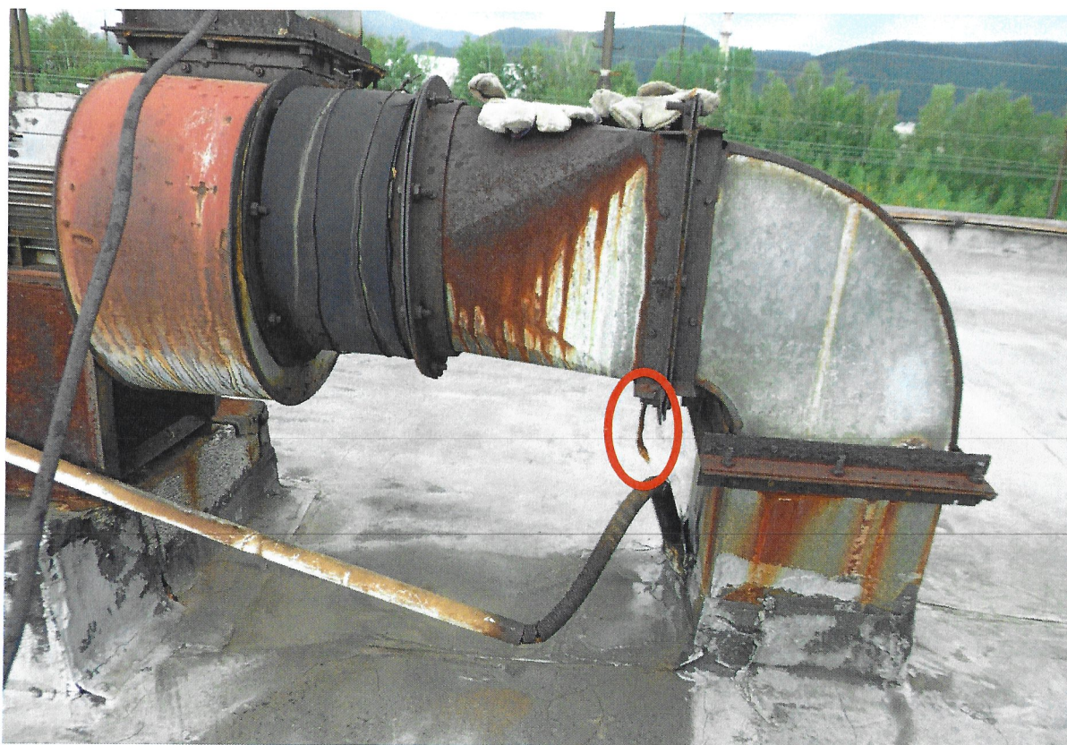
Foto č. 7 – Lokalizace místa odběru vzorku č. 5. Dvoupodlažní část VB, střecha. Azbestová těsnící šňůra v přírubě potrubí ventilátoru.
