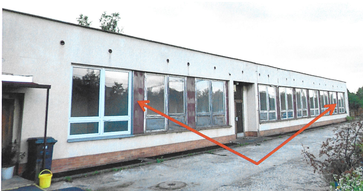
Foto č. 8 – 2.NP výpravní budovy směrem ke kolejišti. Meziokenní vložky obsahující azbestové desky .
