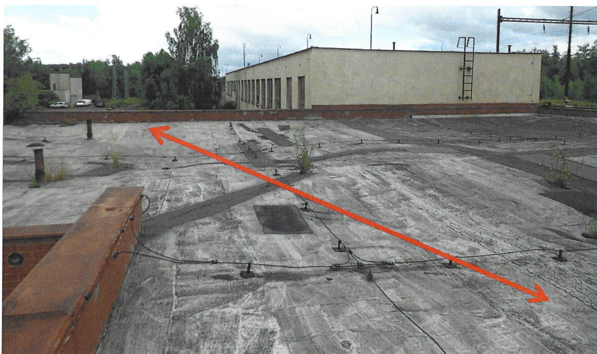
Foto č. 9 – Střešní plocha jednopodlažní části VB. Azbestové souvrství asfaltových pásů .
