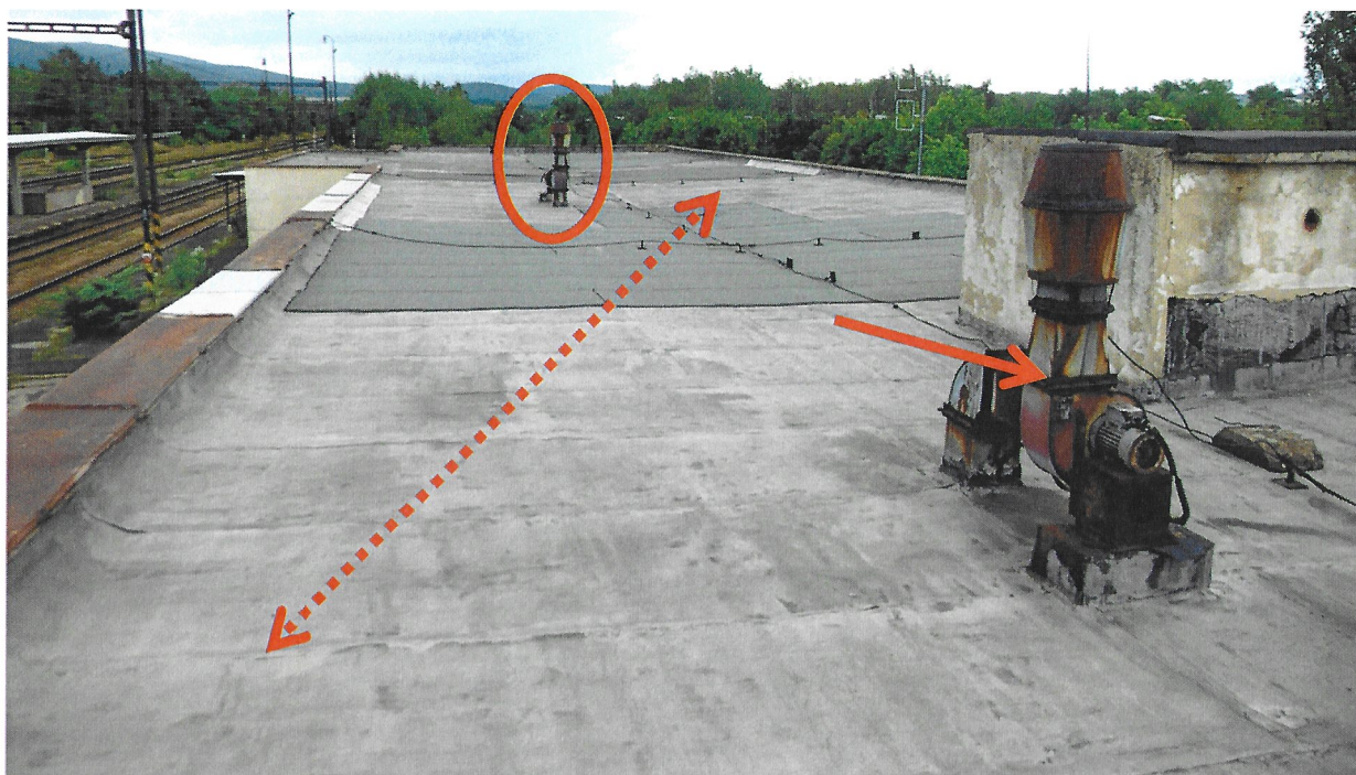
Foto č. 10 – Střešní plocha dvoupodlažní části VB. Azbestové těsnící šňůry v přírubách dvou ventilátorů. Pravděpodobný výstyt azbestu v souvrství asfaltových pásů .
