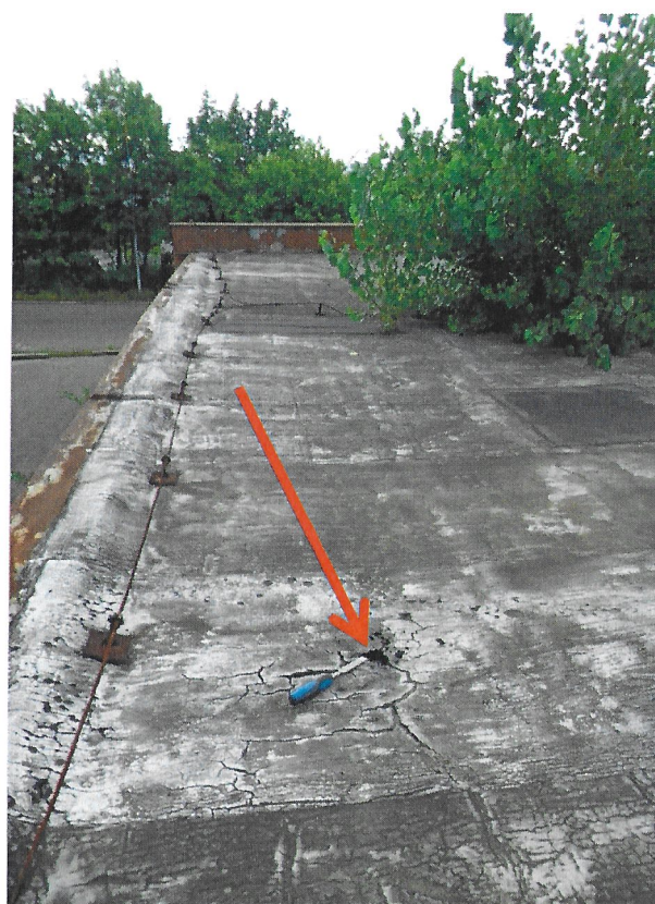
Foto č. 6 – Lokalizace místa odběru vzorku č. 4. Jednopodlažní části VB. Azbestové souvrství asfaltových pásů jako střešní krytina.
