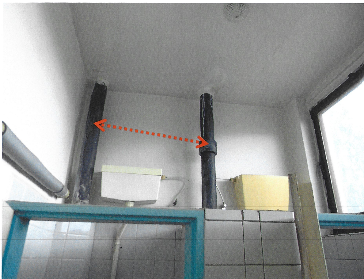
Foto č. 11 – Dvoupodlažní část VB, 2.NP, m.č. 220 a 221 toalety dveře č. 15. Části dvou stoupacích potrubí tvořené azbestocementovými rourami .
